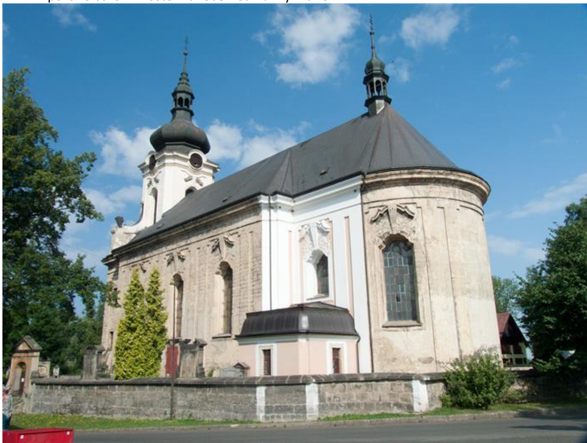
Obr. 3.7 Pozdně barokní kostel Nanebevzetí Panny Marie
