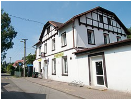
Obecní úřad obce Labská Stráň
